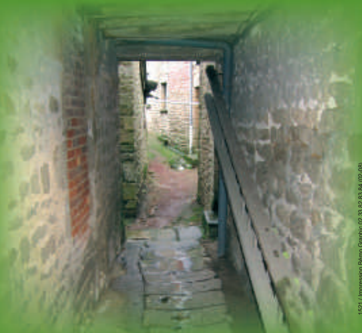
Porche avec dalles en granit
